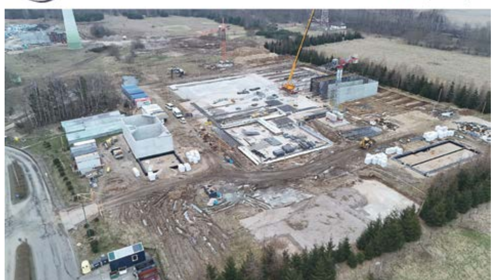
Rys. 3 Stan robót na dzień 13.02.2025 r.
