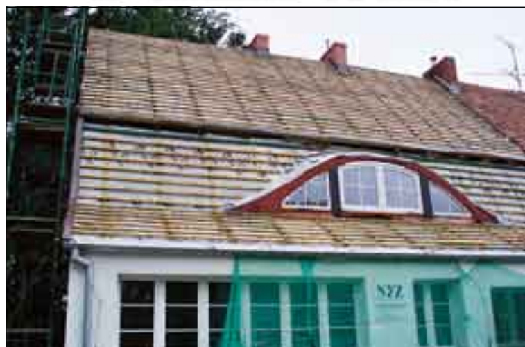
Remont dachu ośrodka zdrowia w Bałątku
