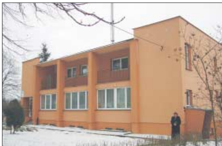
Kompleksowo wyremontowane budynki gminnych ośrodków zdrowia w Budowie.
