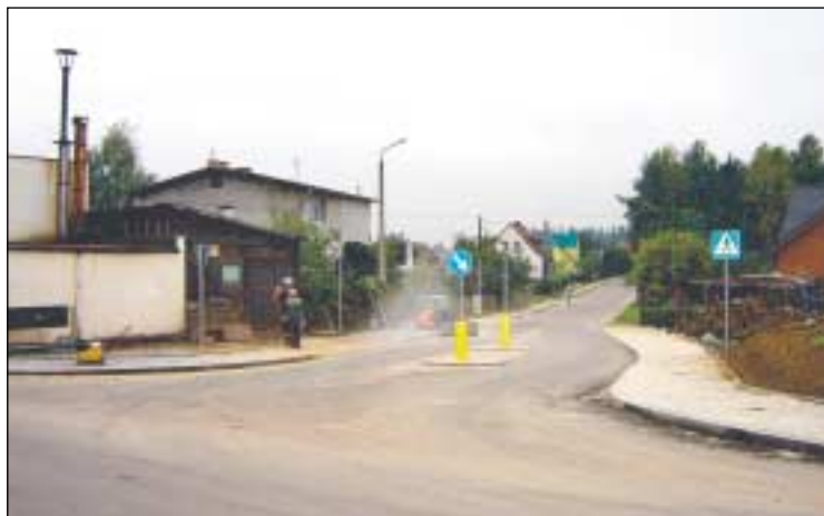
Remont ulicy Kościelnej w Dębicy Kaszubskiej wraz z przebudową skrzyżowania.
