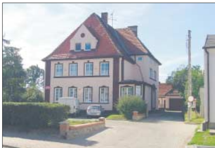
Kompleksowo wyremontowane budynki gminnych ośrodków zdrowia w Dębicy Kaszubskiej.
