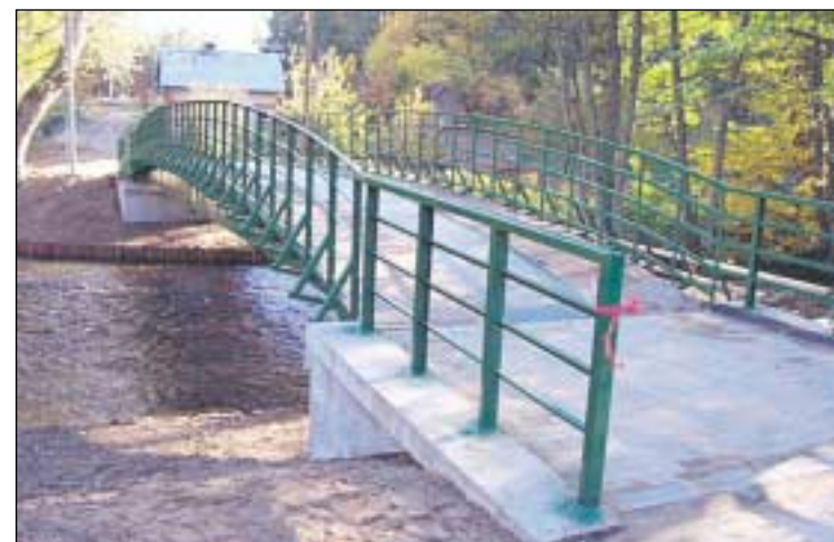
Wyremontowany i przebudowany most na rzece Skotawie w Skarszowie Dolnym.
