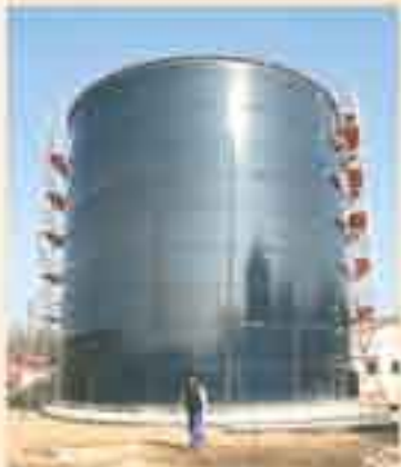
Zamknięta komora fermentacyjna, w której będzie wytwarzany biogaz
