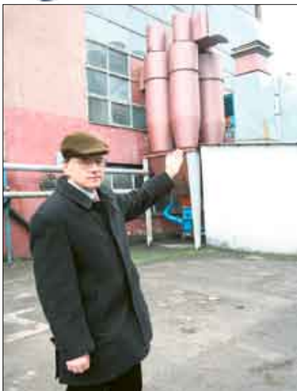
Prezes EMPEC Ireneusz Zagrodzki pokazuje multicyklony oczyszczające spaliny w kotłowni rejonowej
