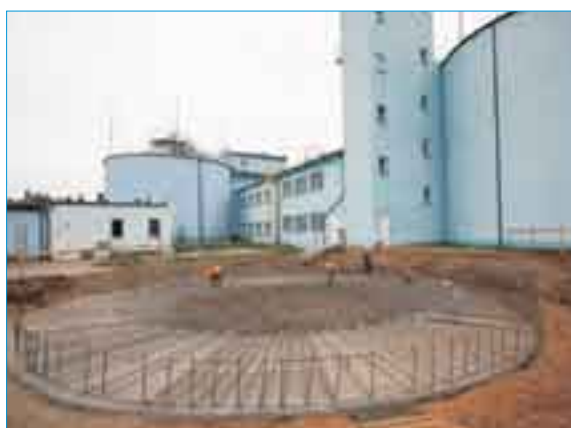
Na zdjęciu: W ten sposób powstaje płyta dena ZKF.
