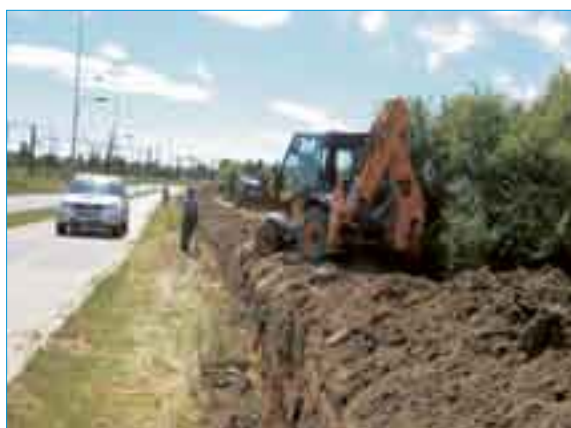
Na zdjęciu: Prace w Kobylnicy.
